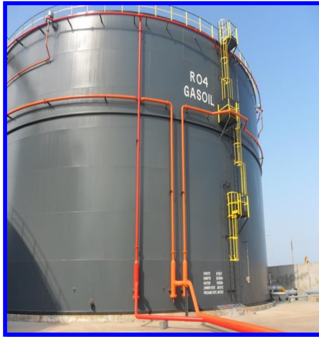
Sablage-peinture Bac Gasoil 16 000M 3 Pour Société Guinéenne de Petrole (SGP-CONAKRY)
