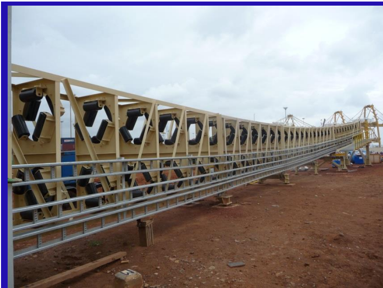
Montage Convoyeur pour minerais Grande Cote Operation (GCO)-port de Dakar
