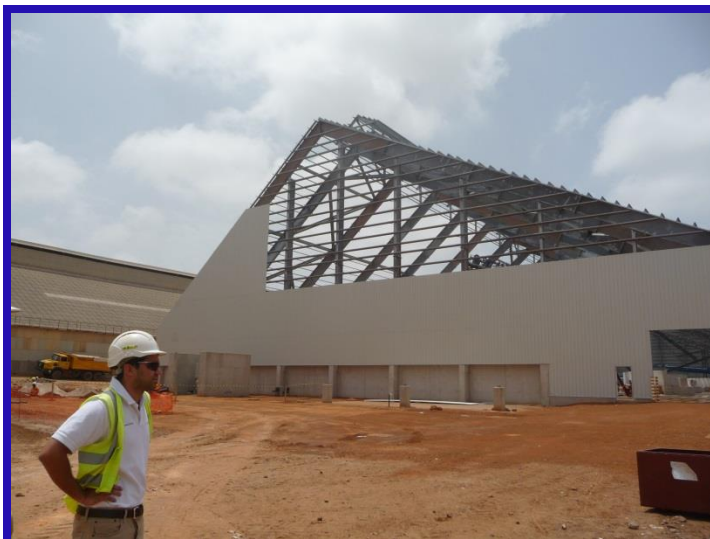
Montage d'un entrepot de stockage de 8 000M 2 ( 65 ml de portée) Pour DAWNUS- Port autonome de DAKAR
