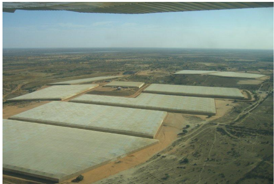
VUE D'ENSEMBLE DE SERRES CANARIENNES DES GDS
